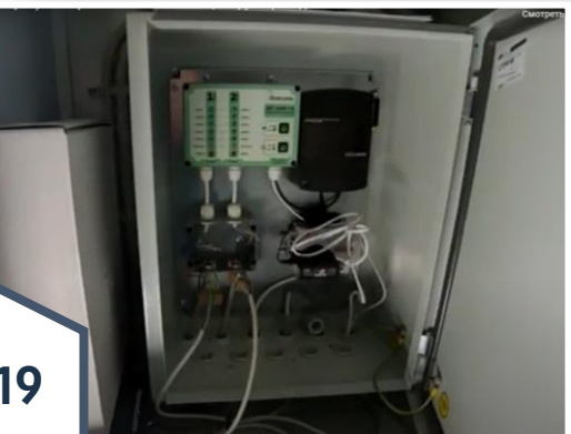
Контроль состояния изоляции трубопровода
